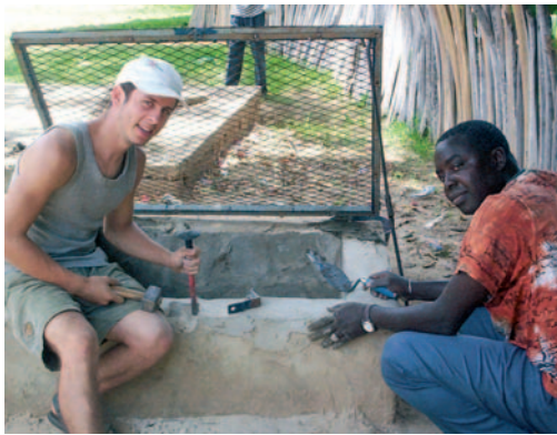
Des incinérateurs permettront de brûler les déchets hospitaliers.
