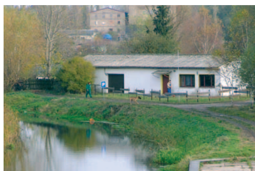
Le toit actuel du hangar à bateaux (en amiante) va être remplacé par une toiture "verte" (couverture végétale).
