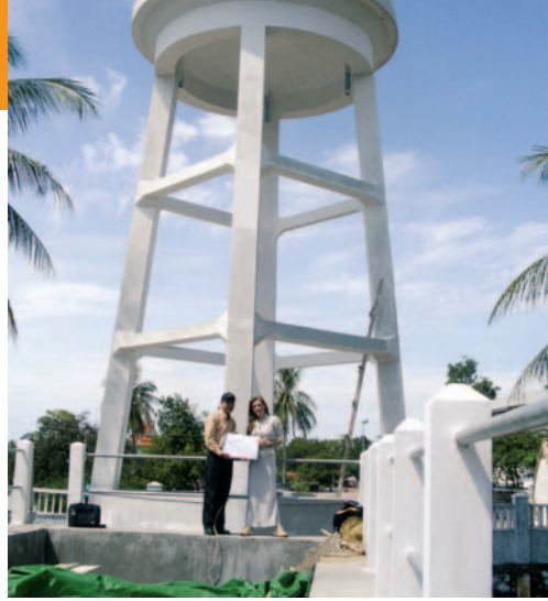
La réalisation de la station et du réseau d'Angkor Borey a bénéficié de l'aide des experts de Veolia Water Force.
