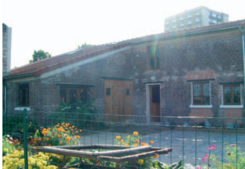
L'ancienne ferme maraîchère a été rénovée dans une démarche d'écoconstruction.
