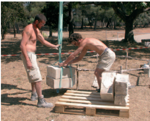
À l'issue du chantier école, les jeunes pourront continuer à se former ou trouver un emploi.
