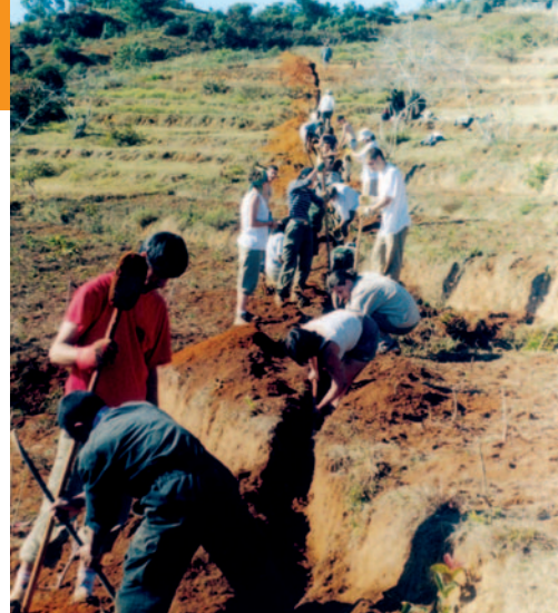
L'adduction d'eau potable sera bientôt complétée par des latrines.
