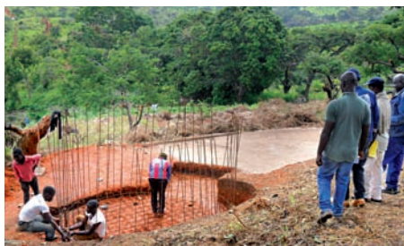
Construction du réservoir à Batchingou
