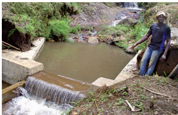
Aménagement d'un captage sur le Mont Batchingou
