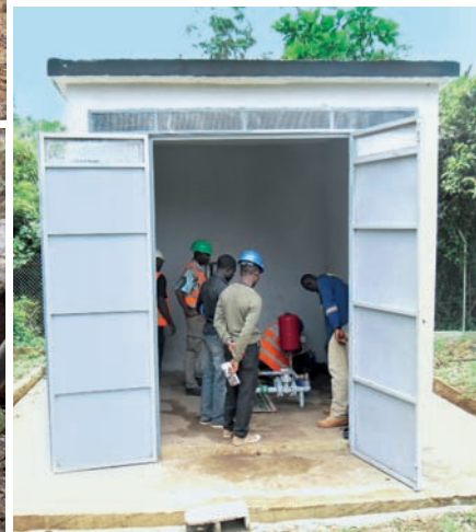
Régénération et sécurisation d'un forage
